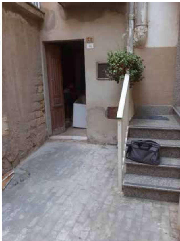
Foto n° 7 Veduta dell'ingresso del magazzino di Via Diaz 44.
